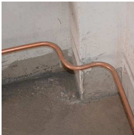
Equipotential grounding conductor
